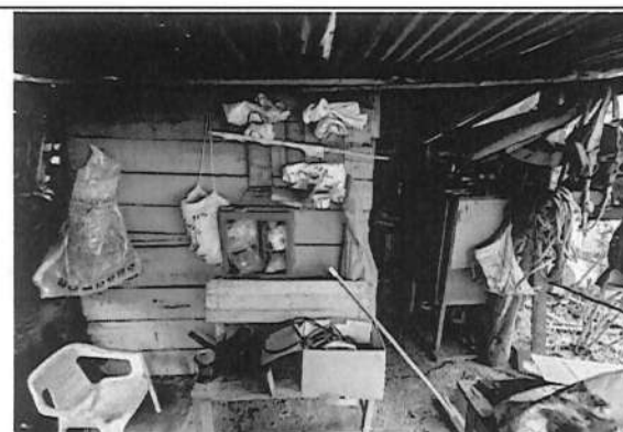
Cuarto de herramientas cerramiento provisional
