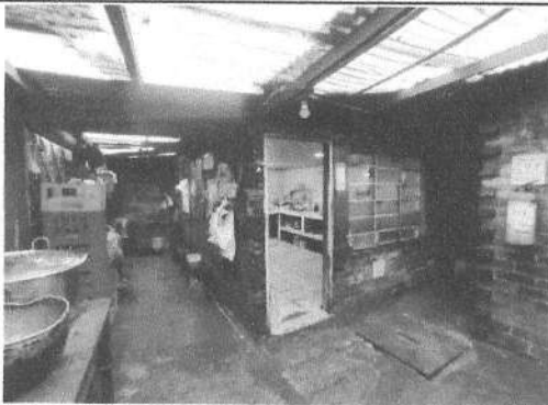
PATIO Y ACCESO A COCINA
