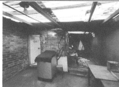
PATIO Y ACCESO A BAÑO
