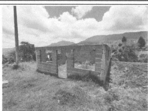
VIVIENDA EN CONSTRUCCIÓN
