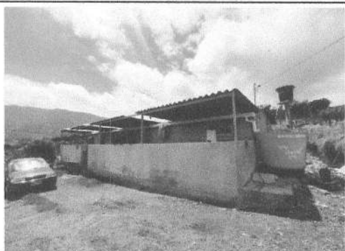
FACHADA PRINCIPAL Y LATERAL DE LA VIVIENDA
