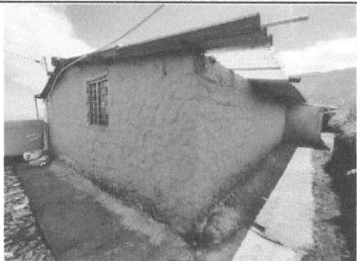
FACHADA LATERAL Y POSTERIOR DE LA VIVIENDA
