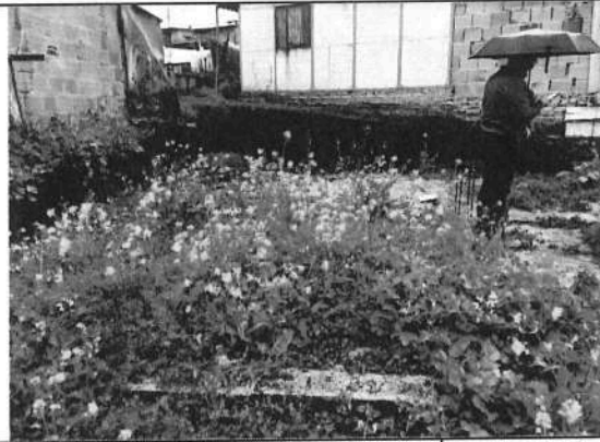
VIGAS DE CIMENTACIÓN
