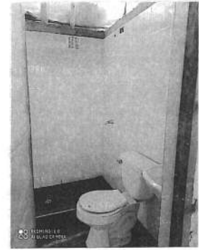
BAÑO DEL ÁREA PRODUCTIVA - PATIO
