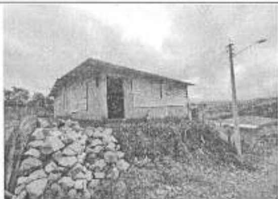
FACHADA PRINCIPAL DE LA VIVIENDA
