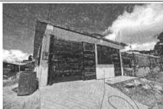
FACHADA PRINCIPAL DE LA VIVIENDA
