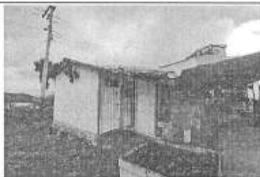
FACHADA LATERAL, ACCESO A BAÑO, PATIO
