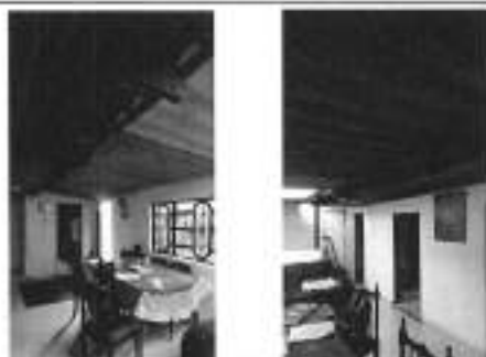
CUBIERTA SALA COMEDOR
