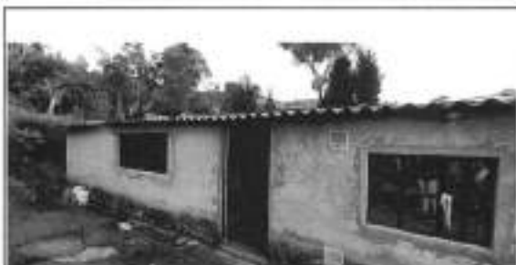
FACHADA PRINCIPAL Y LATERAL DE LA VIVIENDA
