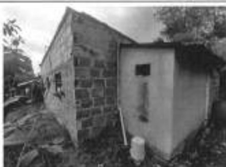
FACHADA POSTERIOR Y LATERAL DE LA VIVIENDA
