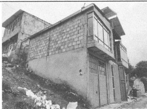
FACHADA PRINCIPAL Y LATERAL DE LA VIVIENDA
