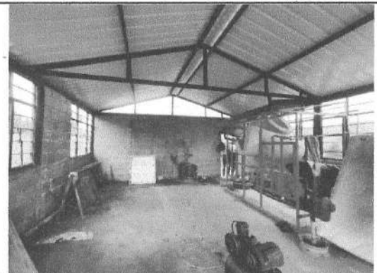
VIVIENDA EN CONSTRUCCIÓN
