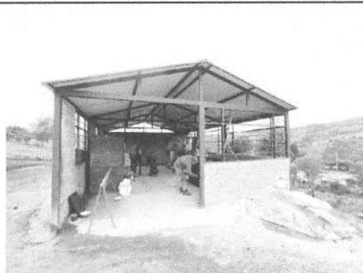
VIVIENDA EN CONSTRUCCIÓN
