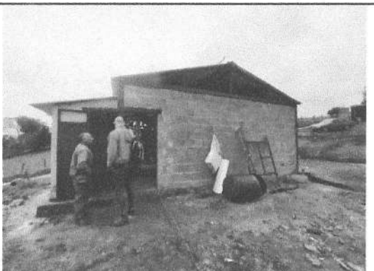
VIVIENDA EN CONSTRUCCIÓN
