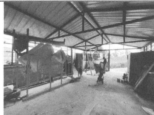
VIVIENDA EN CONSTRUCCIÓN
