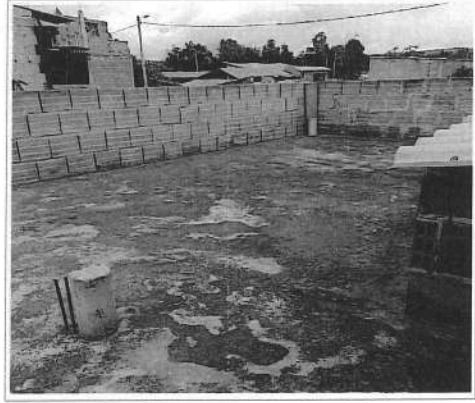
TERRAZA- SEGUNDO PISO EN CONSTRUCCIÓN
