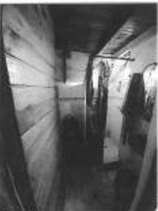
BAÑO 2do PISO
