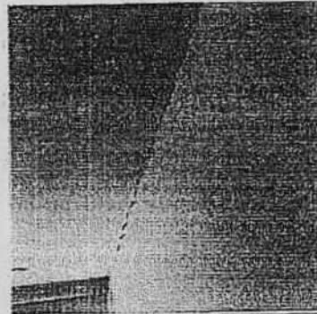
Fotografías 37 y 38. Fisuras entre vértices de muros interiores y placa de entpiso apartamento 404- fisura típica torre costado sur.
