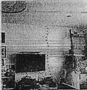
Fotografías 69 y 70. Grietas en muros interiores apartamento 501 torre costado norte.
