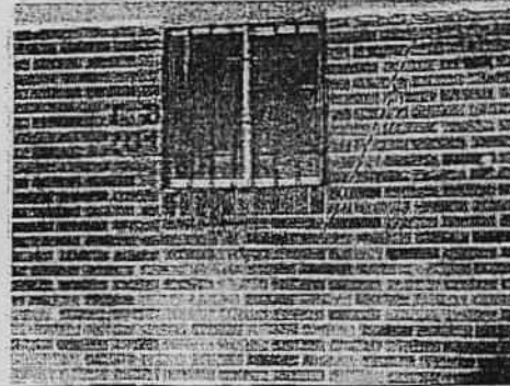
Fotografías 87 y 88. Fisuras en mampuestos muros perimetrales zona de parqueadero.
