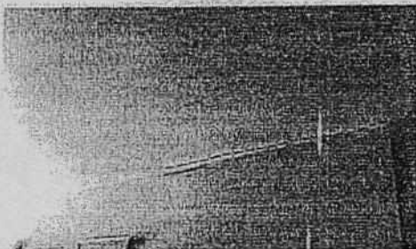
Fotografías 23 y 24. Fisura entre vértices entre muros y placa de entrepiso apartamento 203- fisura típica torre costado sur.
