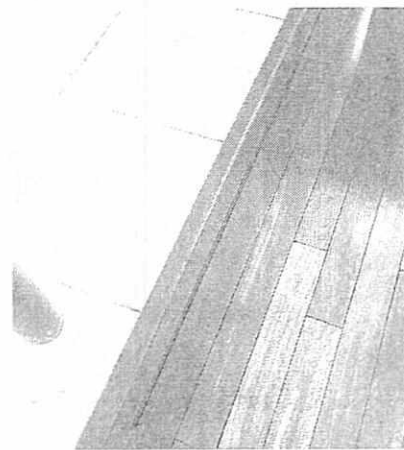
Acabado de piso sala.
