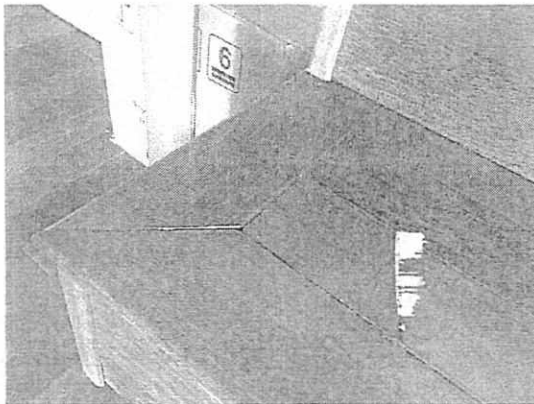
Acabado de piso escaleras.
