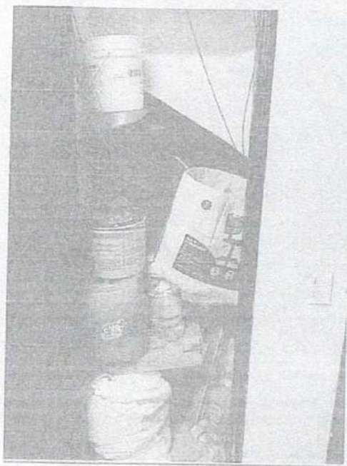
Depósito identificada con el número 14, que en planos de curaduría aparece como 'Disponible no habitable', el cual está lleno de sobrantes de construcción.
