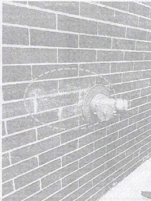
Limpieza de ladrillo pendiente en conexión bomberos, fachada principal
