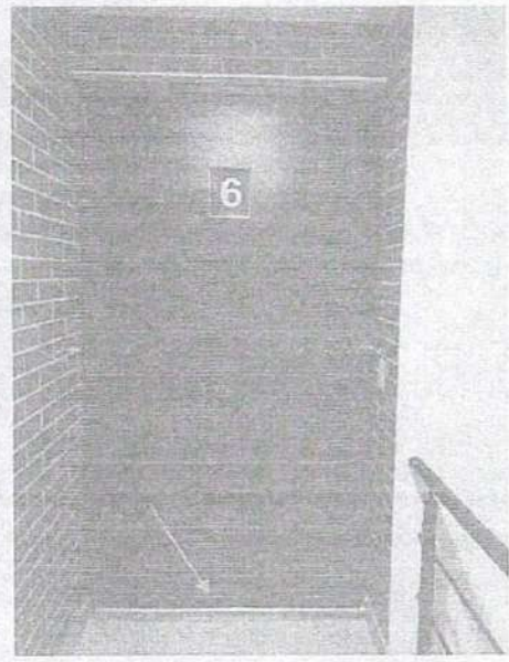
Perfil plástico instalado en la parte inferior de la puerta de acceso a la terraza, como solución para evitar el ingreso de aguas lluvias al punto fijo.
