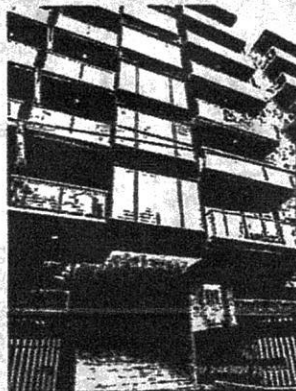
Registro fotográfico No. 1.0. C. R. EDIFICIO PRADOS DEL COUNTRY
