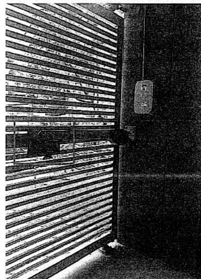
Brazo electromecánico, pletina de acero.
