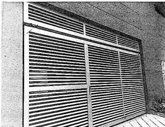
Puerta vehicular fachada principal.
