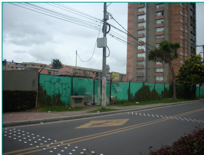
Imagen No.17: Vía de acceso.
