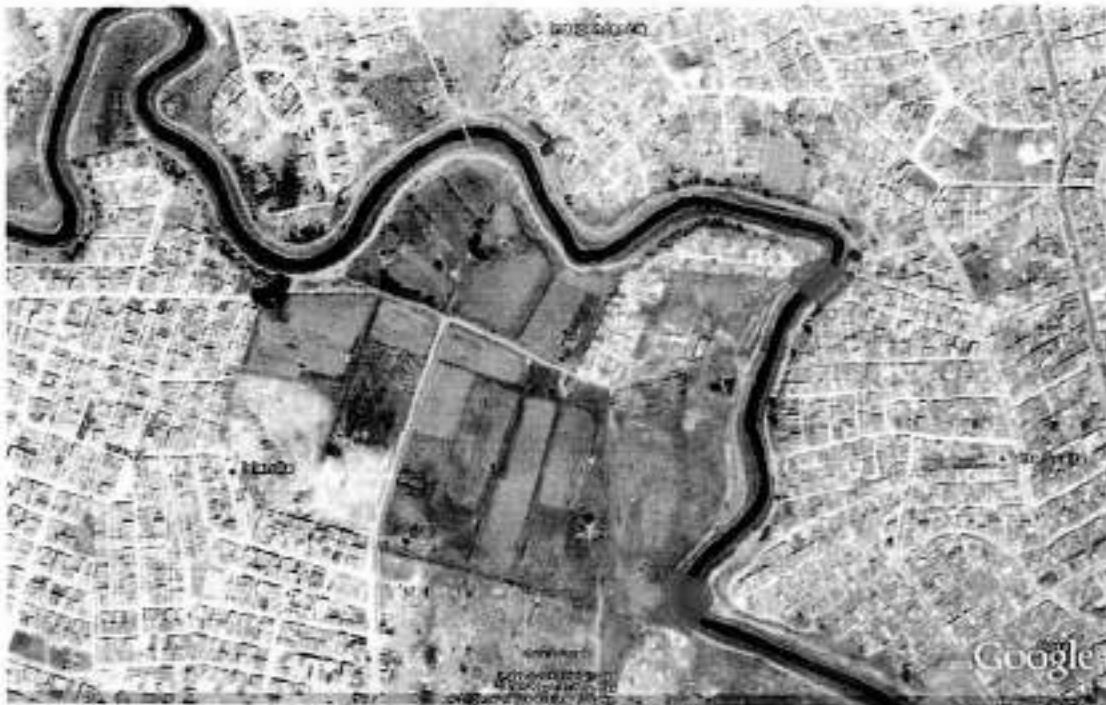
Figura 4. Zonas con jarillones bajos en la margen izquierda en el plan parcial "LA PALESTINA" de acuerdo con la topografía entregada por la EAAB
