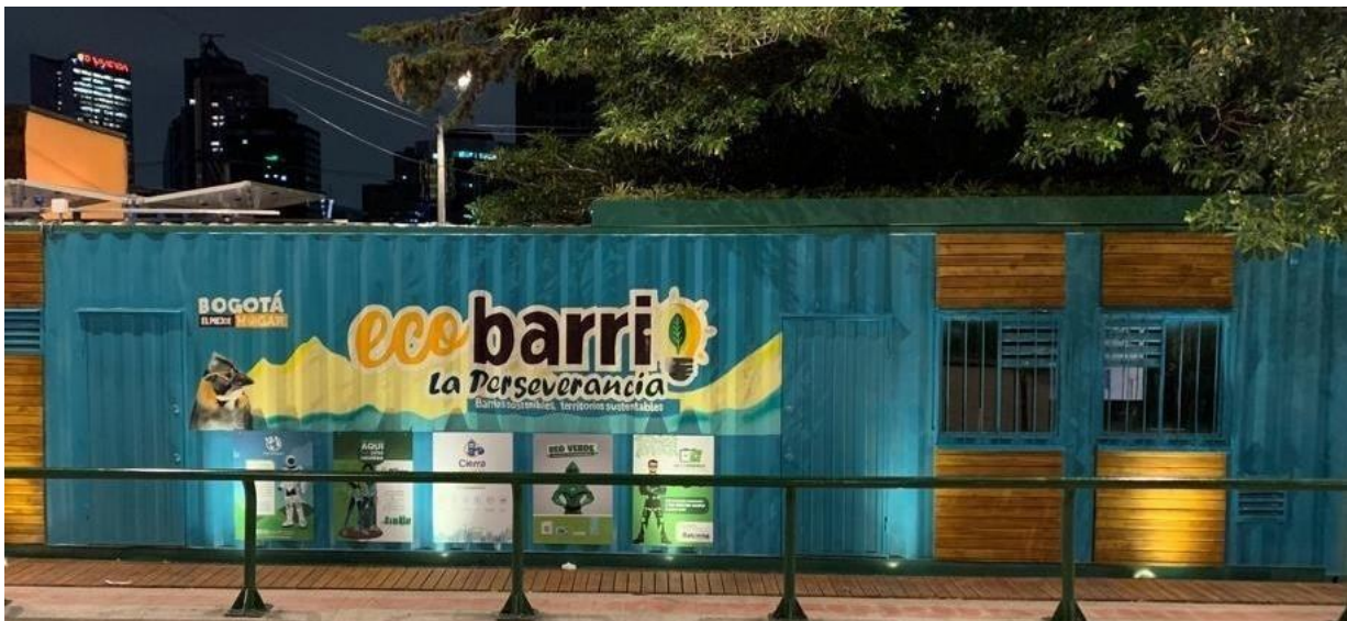
Fuente: Subdirección de Operaciones-SDHT
