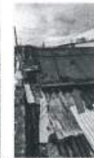
CUBIERTA EN ABRETO CEMENTO Y REFORZADO DE PLASTICO (FIBRA)
