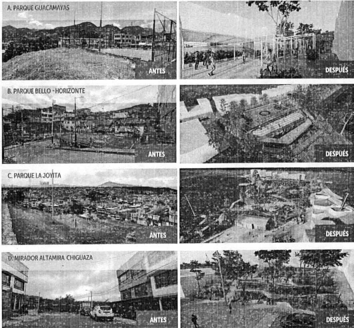
Ilustración No 5 Obras de Revitalización Cable Aéreo San Cristóbal
