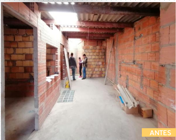
Mejoramiento de vivienda.
