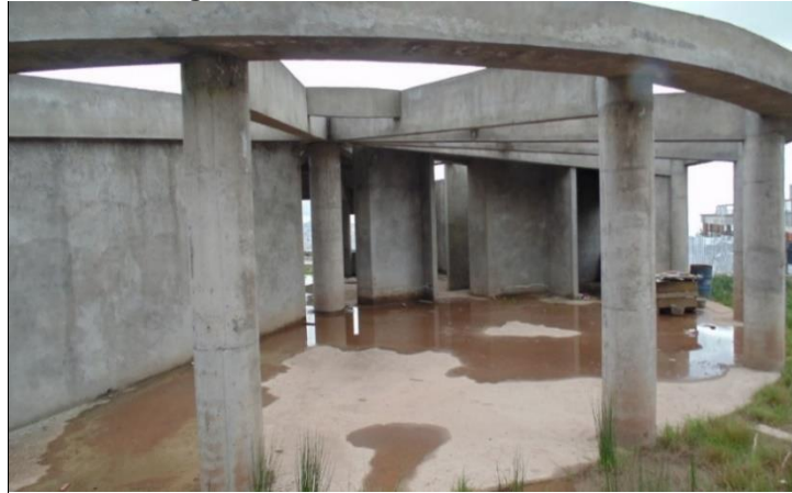
Imagen No. 15 Salón comunal Sector II
