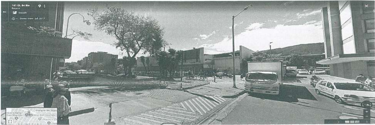
Fachada Carulla sobre calle 84
