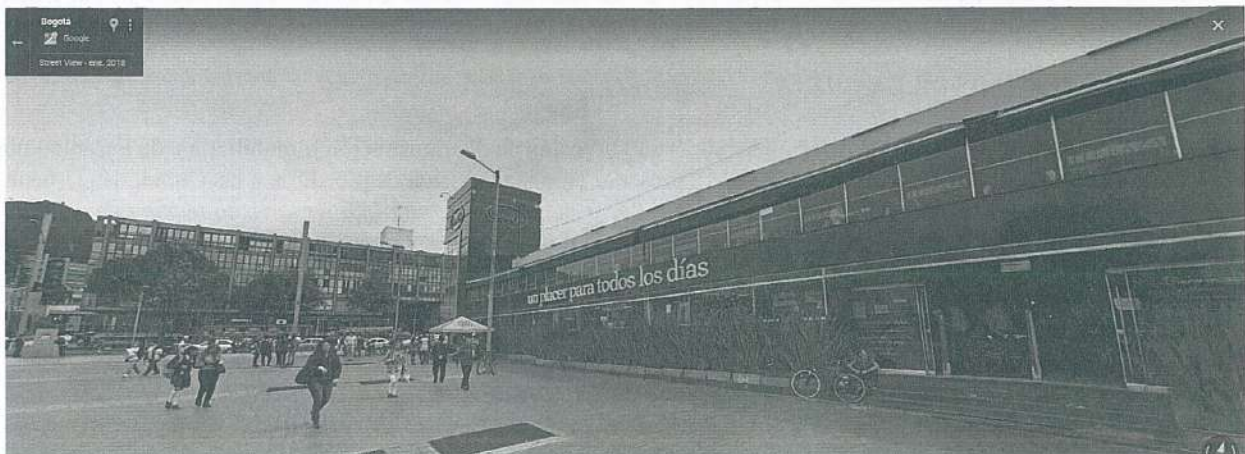
Fachada Carulla sobre calle 85
