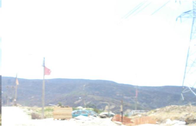
Líneas de alta tensión
