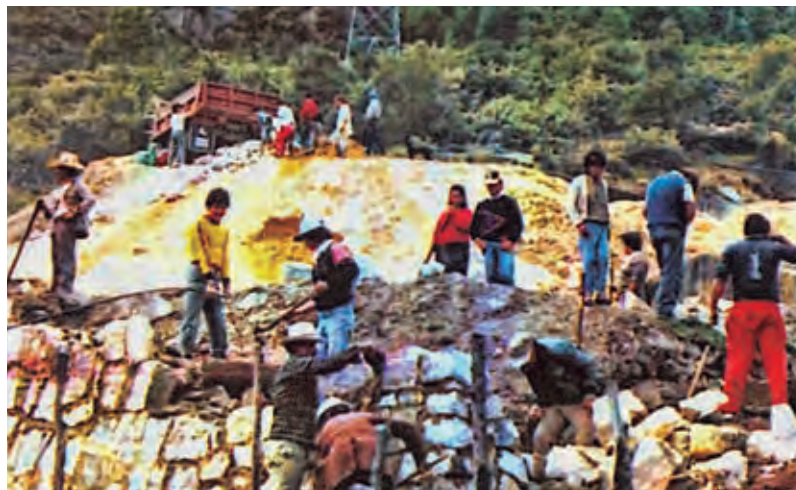
Construcción del acueducto comunitario.
