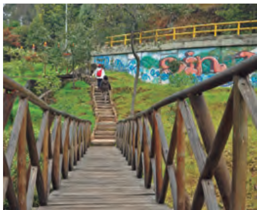
Puentes en madera a lo largo del sendero.
