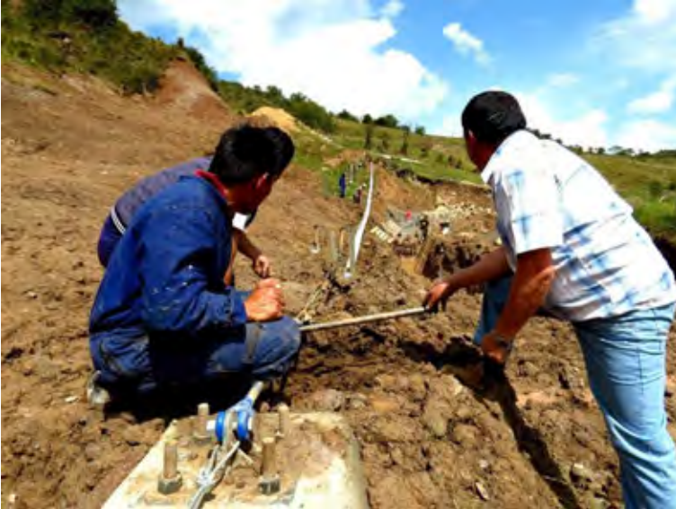
Construyendo el acueducto.
