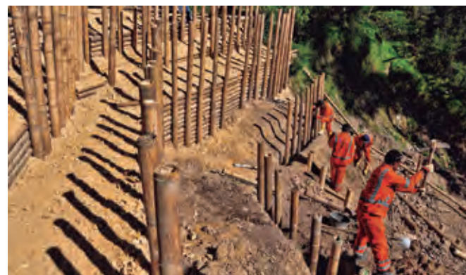
Obra de bioingeniería Barrio Manantial, Triángulo Alto y Bajo, realizada por el IDIGER.
