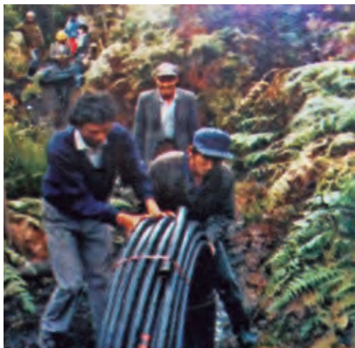
Construcción del acueducto comunitario.
