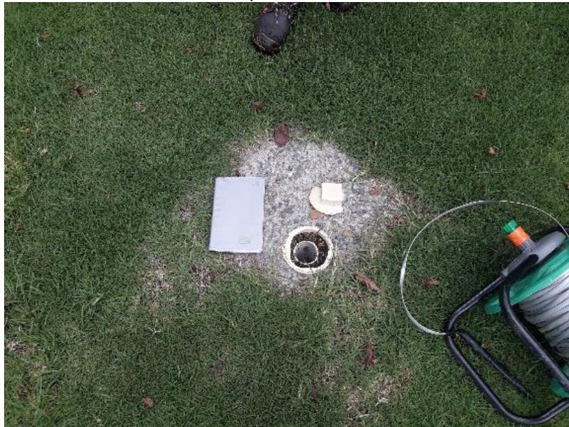
Fotografía 28 Piezómetro JP POZO N6, Cementerio Jardines de Paz
