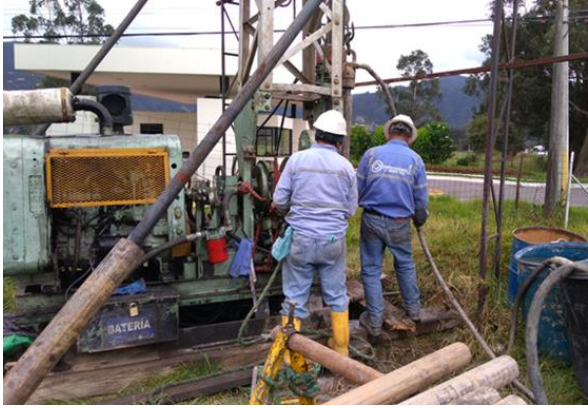
Fotografía 36 Construcción del Piezómetro PZ-WSP-3-PREDIO EL MIMBRE e instalación del diver (Serial AR-206)
