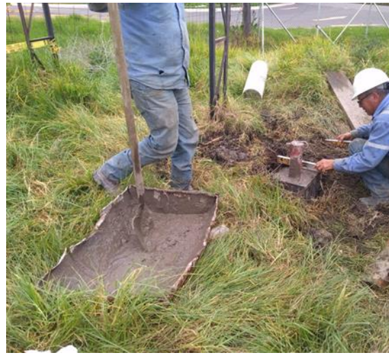
Fotografía 36 Construcción del Piezómetro PZ-WSP-3-PREDIO EL MIMBRE e instalación del diver (Serial AR-206)
