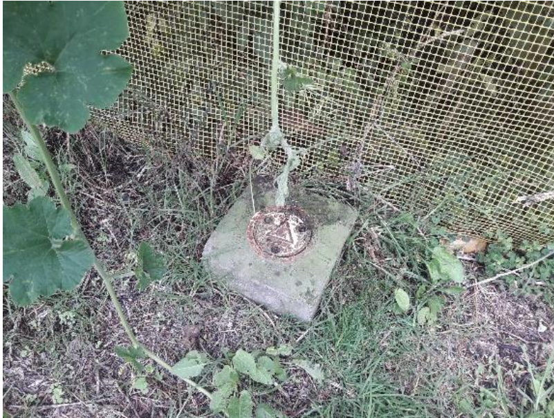
Fotografía 21 Piezómetro PZ-6, Centro comercial Bima
