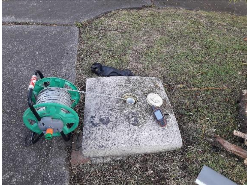
Fotografía 27 Piezómetro JP POZO N3, Cementerio Jardines de Paz
