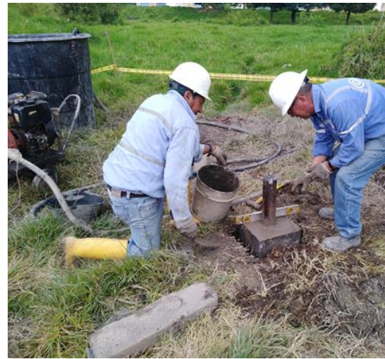
Fotografía 37 Construcción del Piezómetro PZ-WSP-4-PREDIO VALMARIA e instalación del Diver (Serial W6000)
