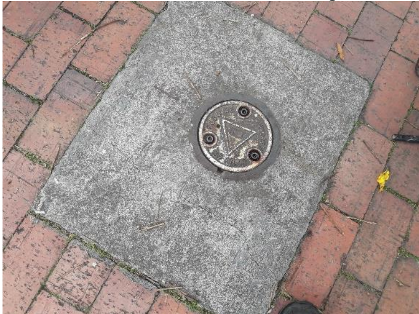
Fotografía 24 Piezómetro PZ-19, Escuela Colombiana de Ingeniería
