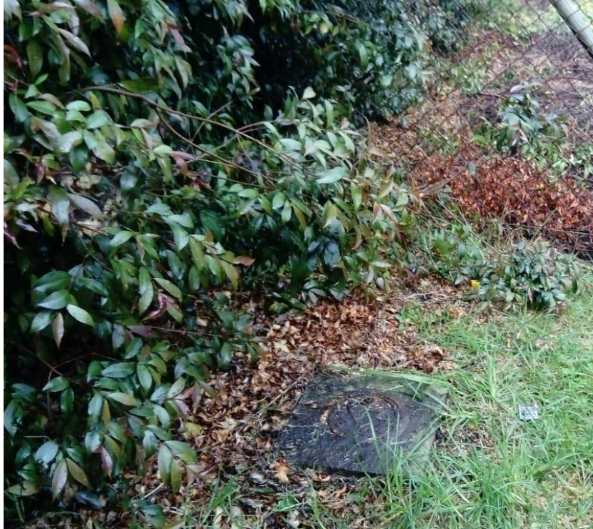
Fotografía 23 Piezómetro PZ-16, Colegio La Enseñanza
