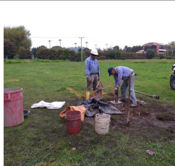
Fotografía 35 Construcción del Piezómetro PZ-WSP-2-PREDIO FAC e instalación del diver (Serial AR-133)
