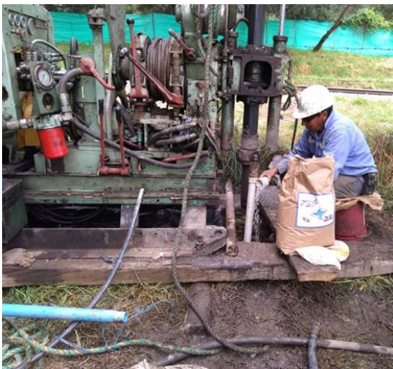
Fotografía 34 Construcción del Piezómetro PZ-WSP-1-PREDIO EAB e instalación del diver (serial AR-137)
