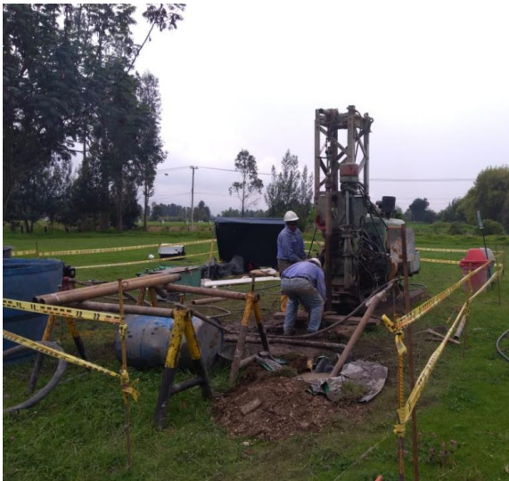
Fotografía 35 Construcción del Piezómetro PZ-WSP-2-PREDIO FAC e instalación del diver (Serial AR-133)
