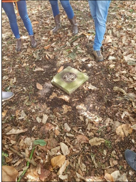
Fotografía 19 Piezómetro PZ-3, Conjunto residencia San Simón 1.
