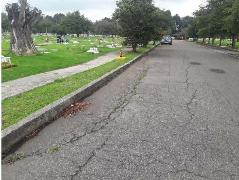
Fotografía 32 Piezómetro JP POZO N5, Cementerio Jardines del Recuerdo
