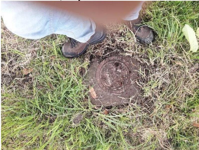
Fotografía 20 Piezómetro PZ-5, Conjunto Residencial San Simón 2
