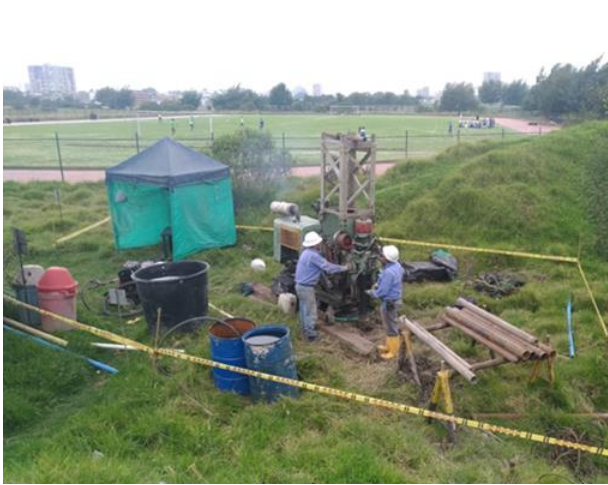
Fotografía 37 Construcción del Piezómetro PZ-WSP-4-PREDIO VALMARIA e instalación del Diver (Serial W6000)
