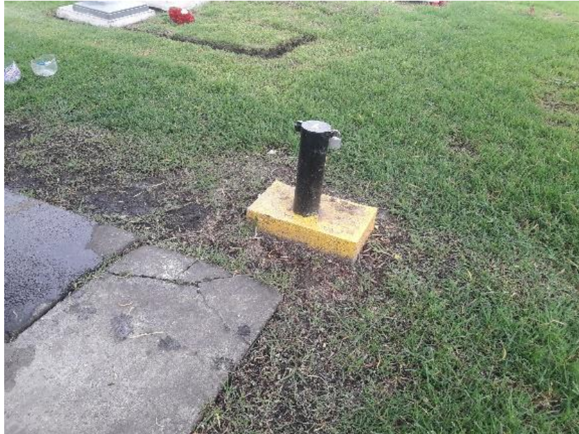
Fotografía 30 Piezómetro JP POZO N2, Cementerio Jardines del Recuerdo
