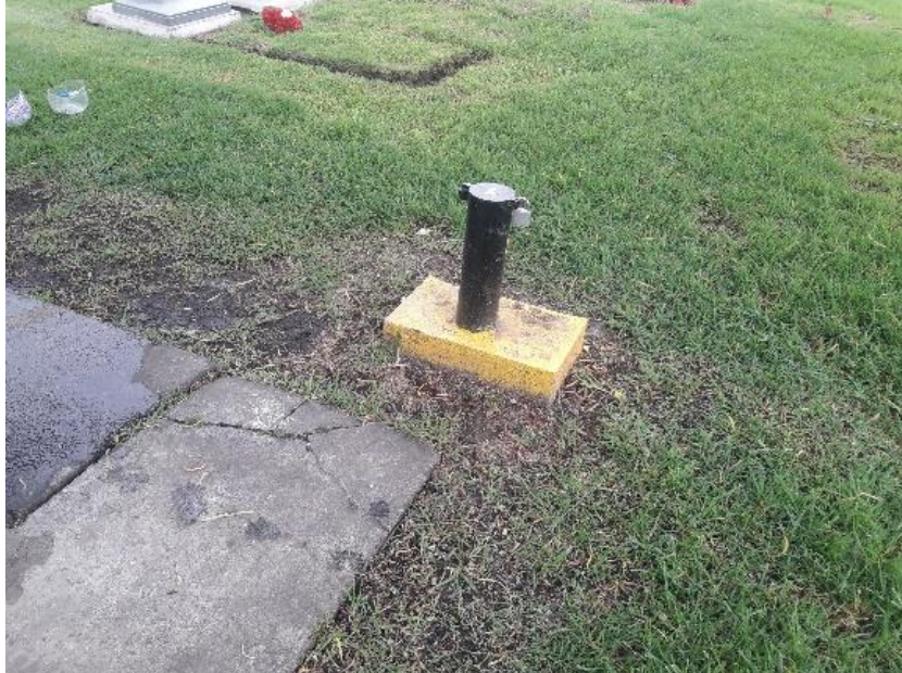
Fotografía 31 Piezómetro JP POZO N4, Cementerio Jardines del Recuerdo
