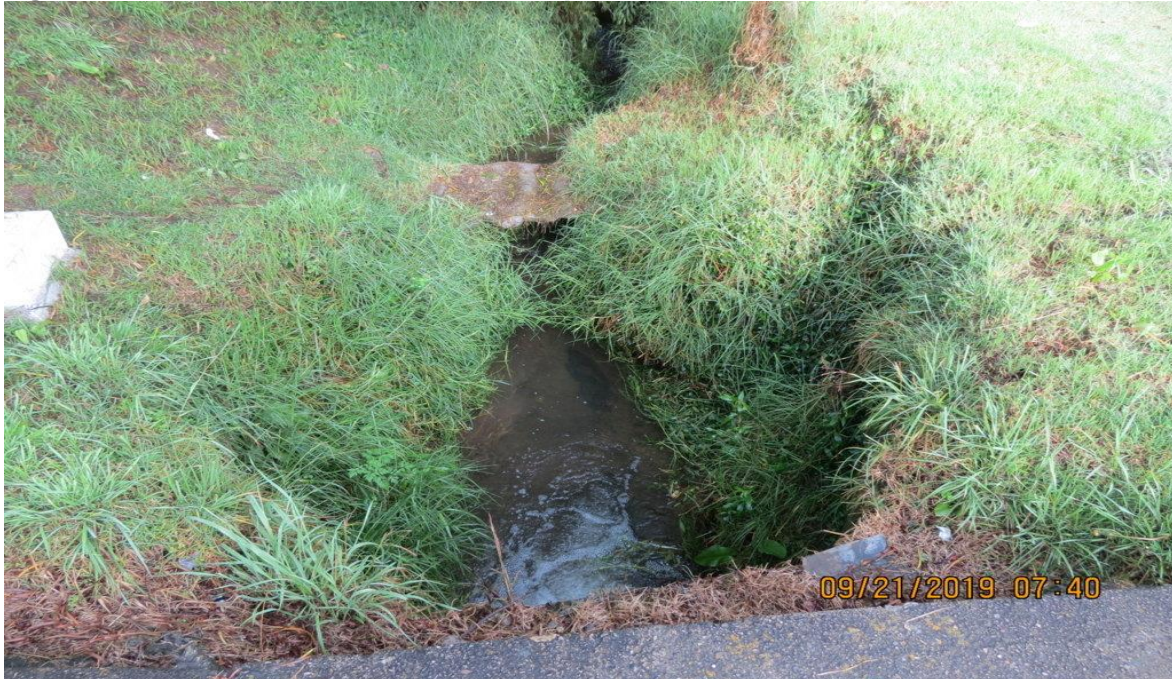
Figura 88 Detalle del cauce actual de la quebrada La Floresta (sector Bima)
