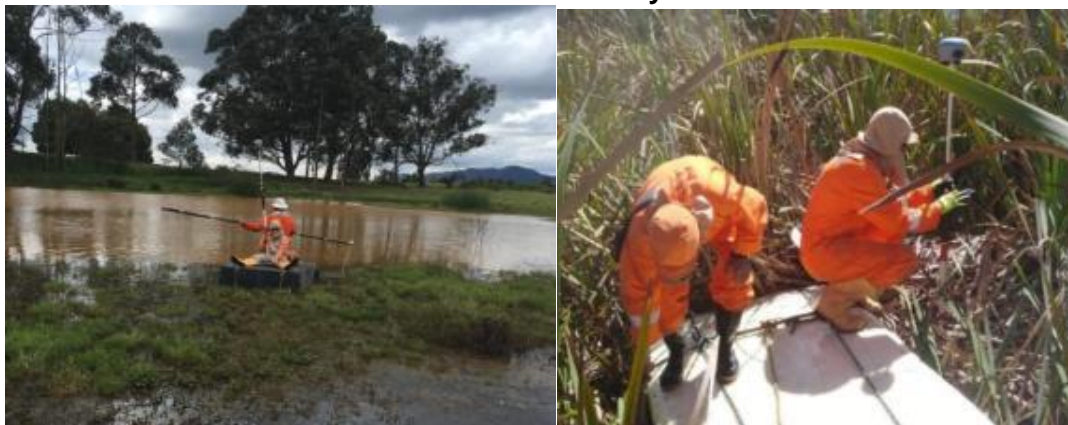
Figura 210. Levantamiento batimétrico de cauces y humedales del sistema hídrico
