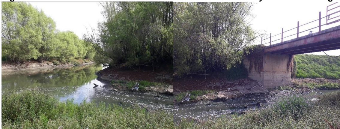
Figura 213. Detalle del sitio de desembocadura del Canal Guaymaral al Río Bogotá
