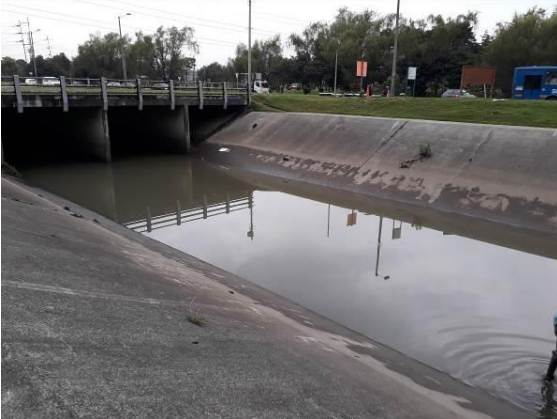
Inspección de estructuras, Canal Torca, entrada a JDP
