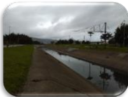
Foto 18. Canal Torca Costado Oriental Autopista Norte
