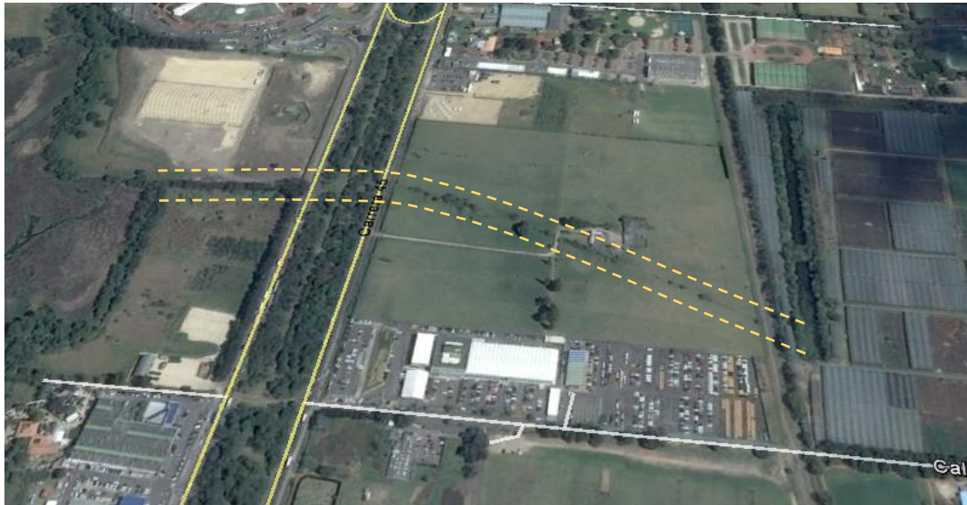
Figura 90. Restauración de la Quebrada las Pilas, incorporada en el Proyecto Ciudad Lagos de Torca. Fuente: Google Earth, 2016.01.27.
