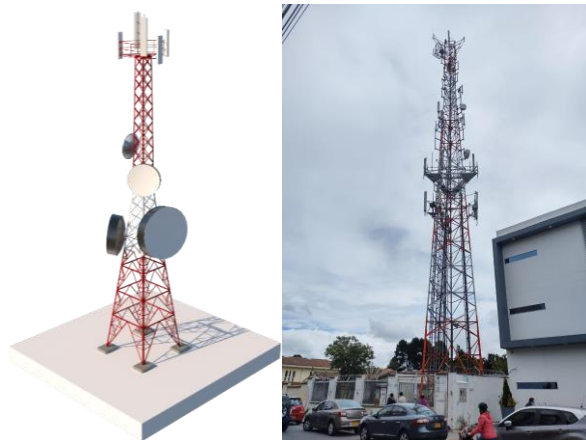
Figura 1.7. Estructura de Soporte – Torre Auto soportada
