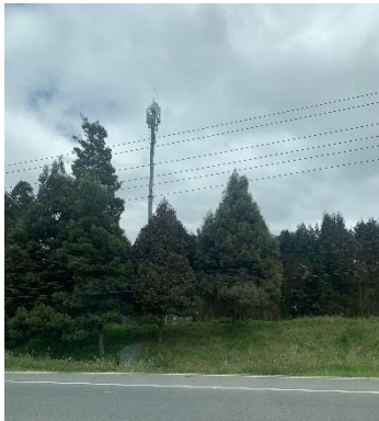
Figura 1.43 – Estaciones Radioeléctricas Localizadas sobre suelo rural
