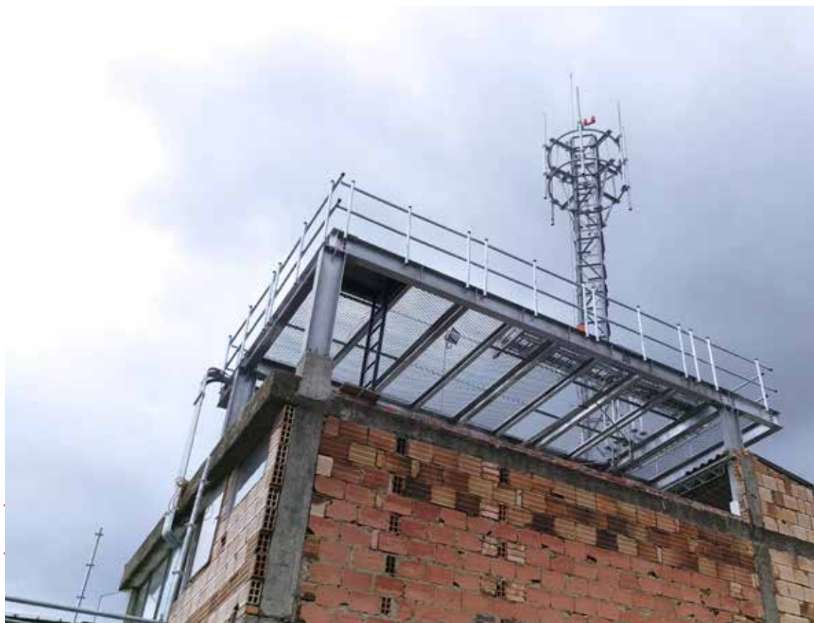
Figura 7.17. Elemento portante no permitido
