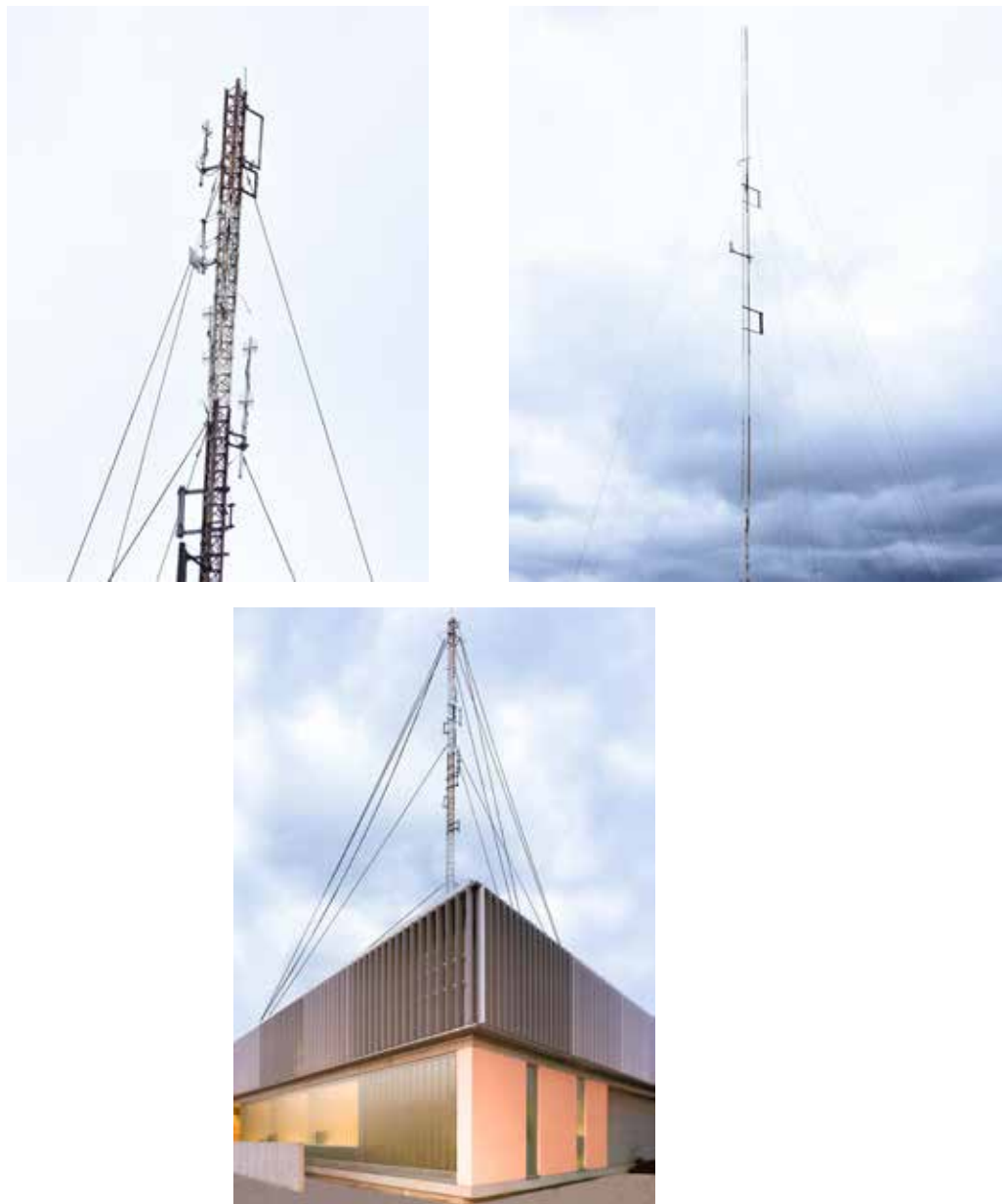
Figura 6.4. Estructuras de soporte arriostradas
