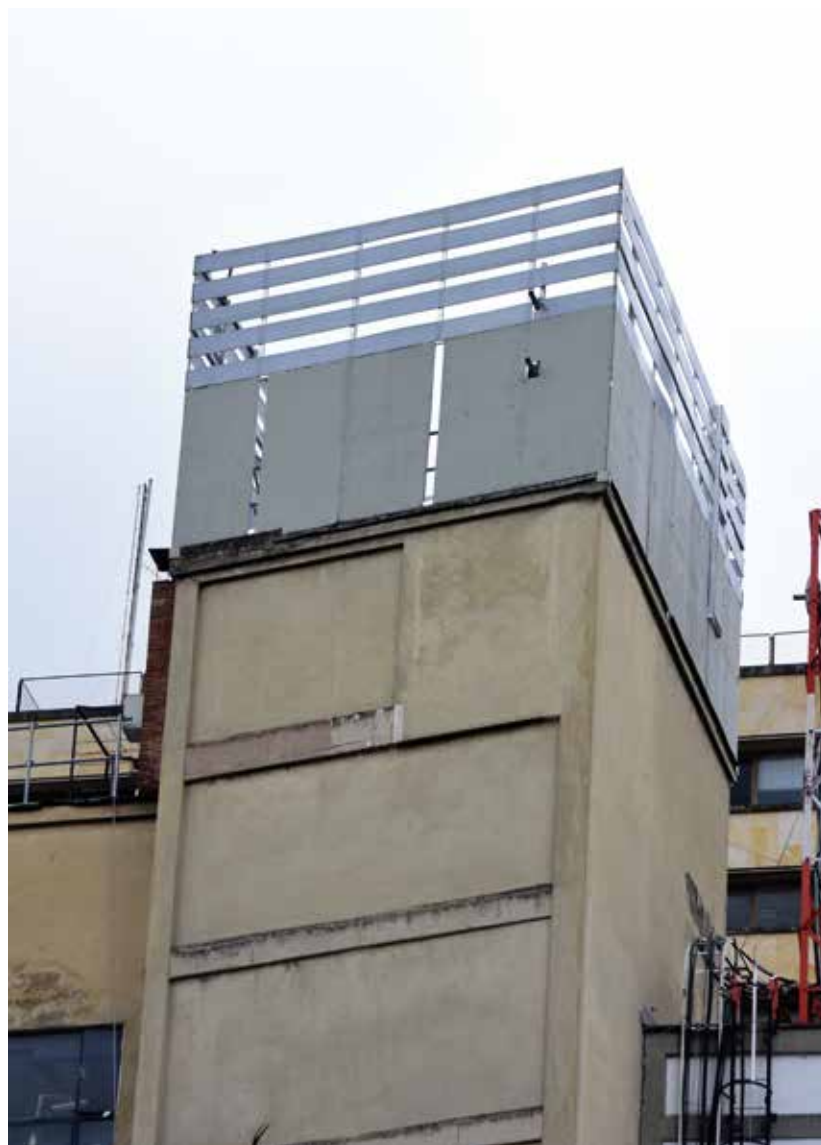
Figura 7.12. Ejemplo de mimetizaciones con estructuras de paneles
